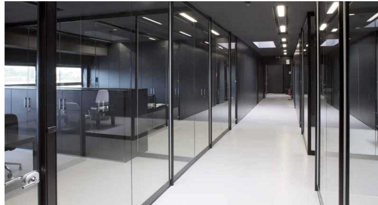
Sistema di partizioni fortemente caratterizzato dal vetro antisfondamento 5+5 mm di spessore e profili in alluminio verniciati a campione con piedini idonei per la regolazione millimetrica a pavimento e soffitto.
