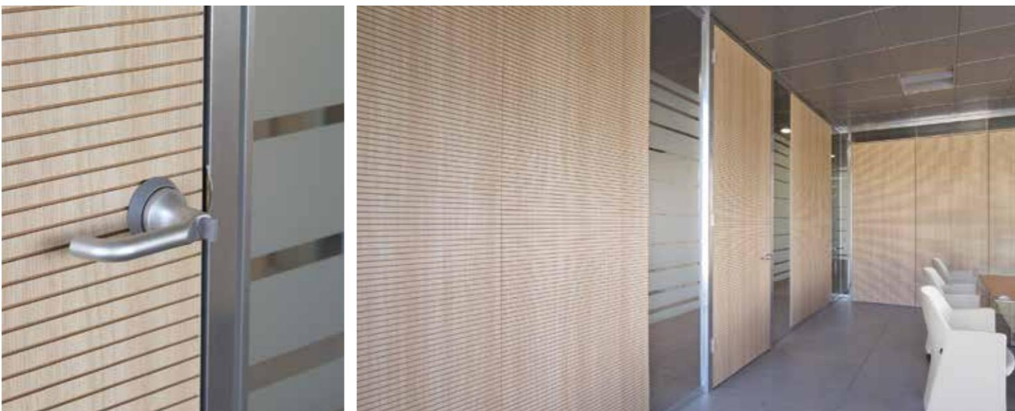
Sala riunione uguale eleganza: pareti divisorie cieche, vetrate e porte realizzate con sistema ad elementi fonoassorbenti a lamelle dogate studiato per raggiungere i più elevati livelli di estetica e qualità del suono in qualsiasi situazione architettonica e con la massima versatilità di installazione.
